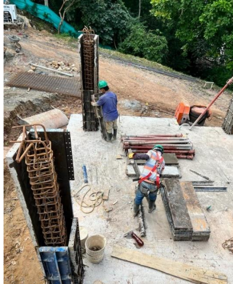
Ilustración 3, Armado de formaleta Casa 14B, Fuente: Autoria Propia
