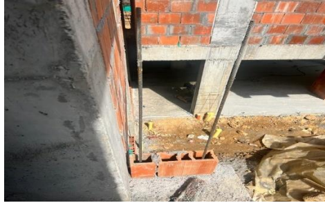
Ilustración 14, Dovelas en muro, Fuente: Autoría propia.
