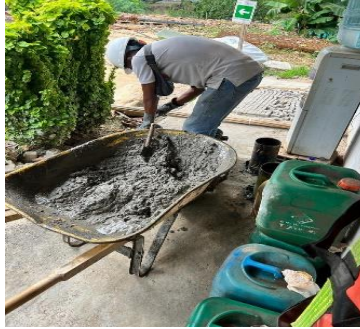
Ilustración 12, Toma de muestras de concreto
