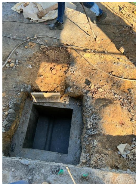
Ilustración 18,Caja de inspección, Fuente: Autoría propia
