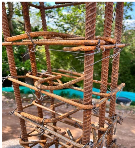
Ilustración 4, Refuerzo de columna
