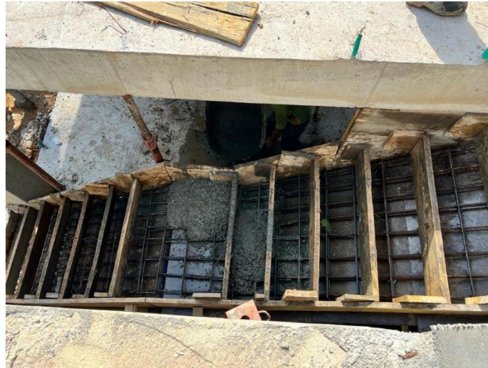
Ilustración 7,Formaleta y Refuerzo de escalera
