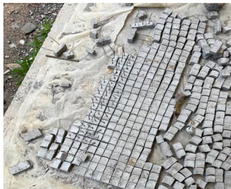
Ilustración 8,Separadores de concreto
